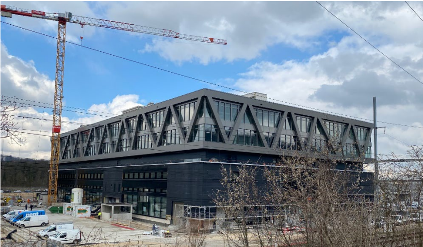
BU: Baufortschritt im uptownBasel (Bildquelle: uptownBasel)
